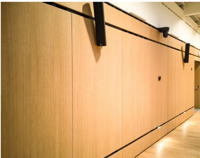
MIKROFORM PANEEL Verlegung: paralleler Verband
