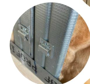
Montage an Trockenbauschiene mittels Montagekralle
