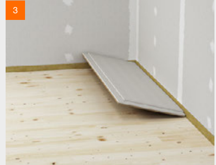
3 Verlegen der fermacell® Estrichelemente
