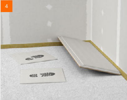
Verlegen der fermacell® Estrichelemente auf fermacell™ Ausgleichsschüttung
