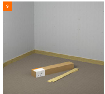
9 Bei Bedarf erfolgt das Anbringen eines Randdämmstreifens
