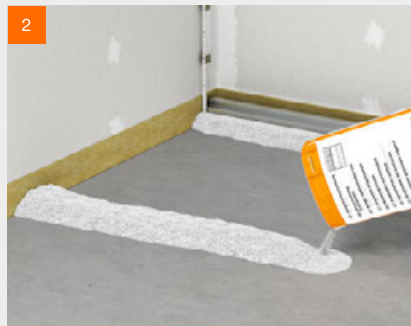
Anlegen der Dämme
