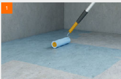
Vorbereitung: Boden grundieren
