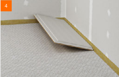
fermacell® Estrichelemente verlegen
