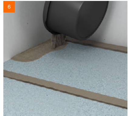
6 Anschliessend wird die fermacell™ Gebundene Schüttung T zwischen den Dämmen ausgebracht ...
