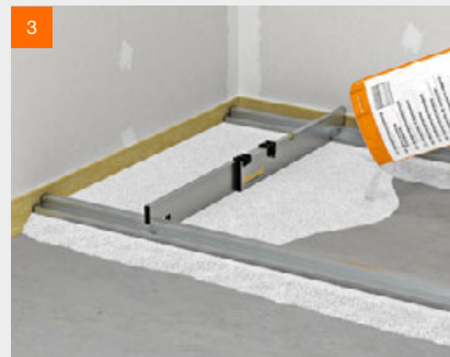
fermacell™ Ausgleichsschüttung einbringen
