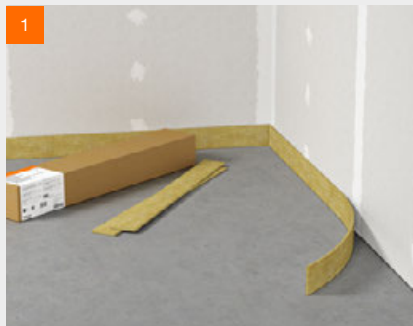
Anbringen der Randdämmstreifen
