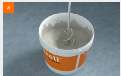
Mit geeignetem Rührgerät bei langsamer Drehzahl anmischen, bis eine homogene, klumpenfreie Nivelliermasse entsteht
