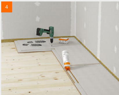
4 Auftragen des fermacell™ Estrichklebers im Falzbereich
