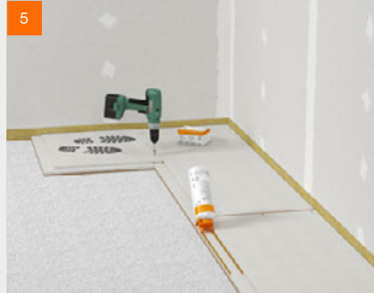
Verlegen der fermacell® Estrichelemente auf fermacell™ Ausgleichsschüttung
