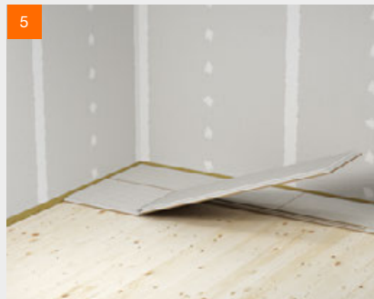
5 Verkleben der Elemente mit vollständig gefüllten Fugen
