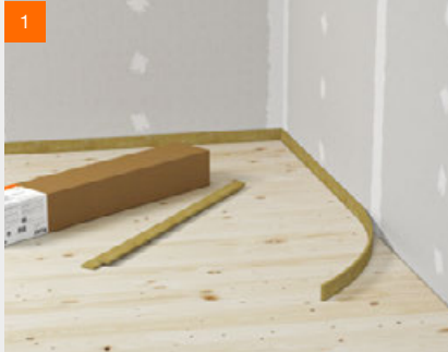
1 Randdämmstreifen verlegen und in den Ecken stumpf stossen
