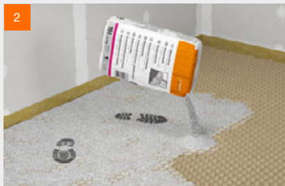
fermacell™ Wabenschüttung einbringen
