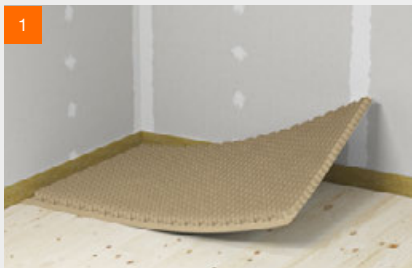
fermacell™ Estrichwabe verlegen
