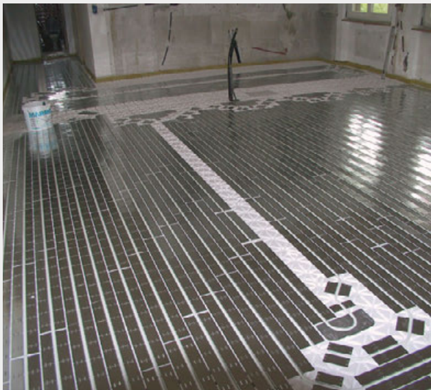
Beispiel 1: fermacell® Gipsfaser Estrichelement 2 E 22 oder Powerpanel TE auf Warmwasser-Fussbodenheizung
