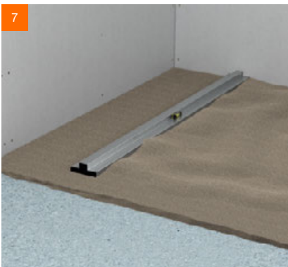
7 ... und auf den leicht verdichteten Dämmen abgezogen
