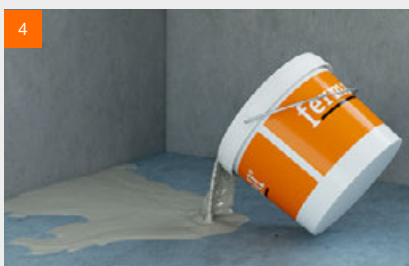
Boden-Nivelliermasse ausbringen und planeben nivellieren
