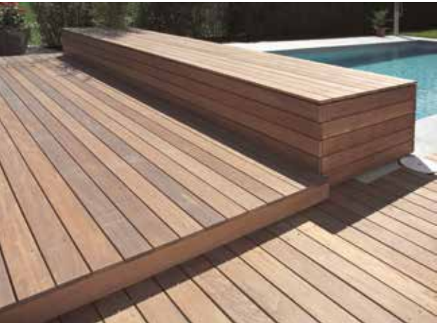
Neuverlegung einer Terrassendiele:
