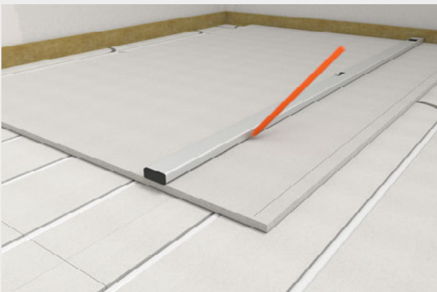
Anzeichnen der Befestigungspunkte und -achsen. Markieren der Befestigungspunkte.
