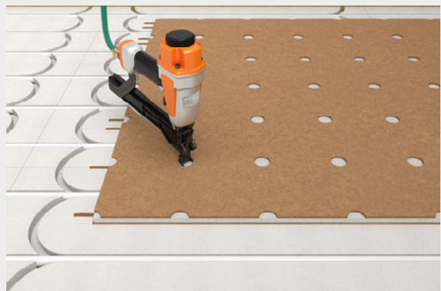
Montage der Abdeckplatte und mechanische Befestigung mittels Schrauben oder Klammern unter Verwendung der Schablone.
