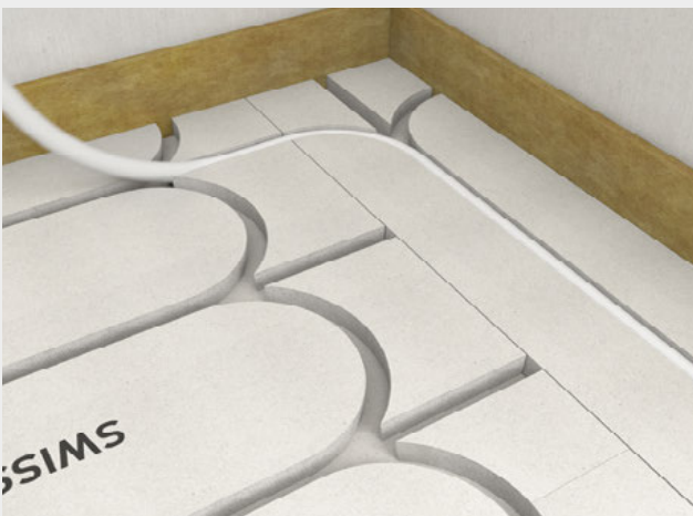
Einbringen der 16mm Heizrohre, spezielle Fräsung erfordert keine zusätzliche Befestigung der Heizrohre
