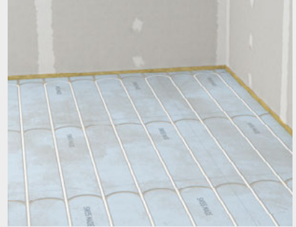
Fertig ausgegossene Therm25™ Elemente (Q1)
