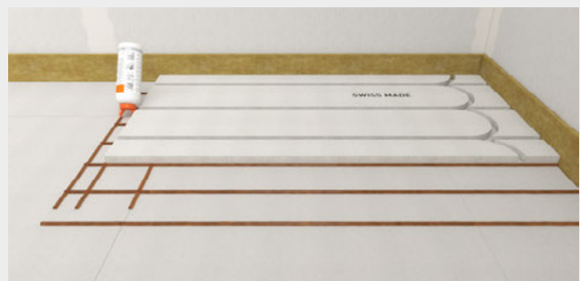
Kleberschnur für die Stossfugenverklebung auftragen
