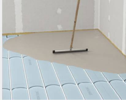
Ausgiessen der Therm25™ Elemente mit fermacell™ Ansetzbinder
