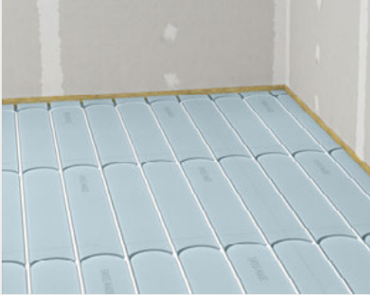
Einlegen der 16mm Fussbodenheizrohre
