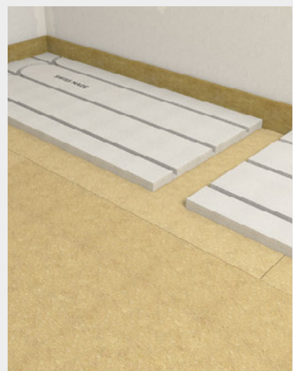
Verlegung der fermacell® Therm25™ Elemente lose verlegt, stumpf gestossen im Kreuzverband
