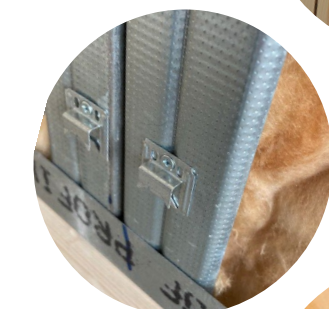
Montage an Trockenbauschiene mittels Montagekralle
