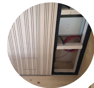
UK aus abgehängten Holzstaffeln und umlaufender Leiste für Schattenfuge
