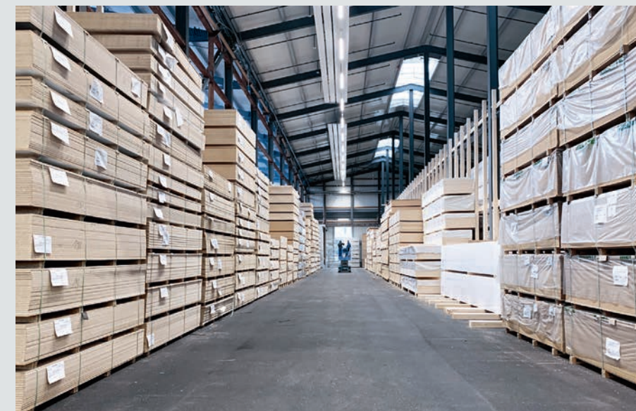
Grossflächige Oblichter und Seitenfenster sorgen im sanierten und erweiterten Mengenlager für ideale Lichtverhältnisse.
