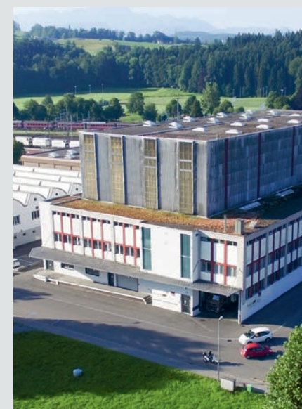
Die gesamte Lagerkapazität ist nach der Erweiterung auf etwa 200 000 Kubikmeter angewachsen.
